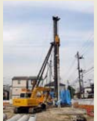
杭打ち始まる
