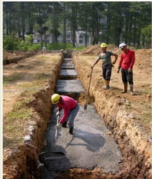
次々進む基礎工事
